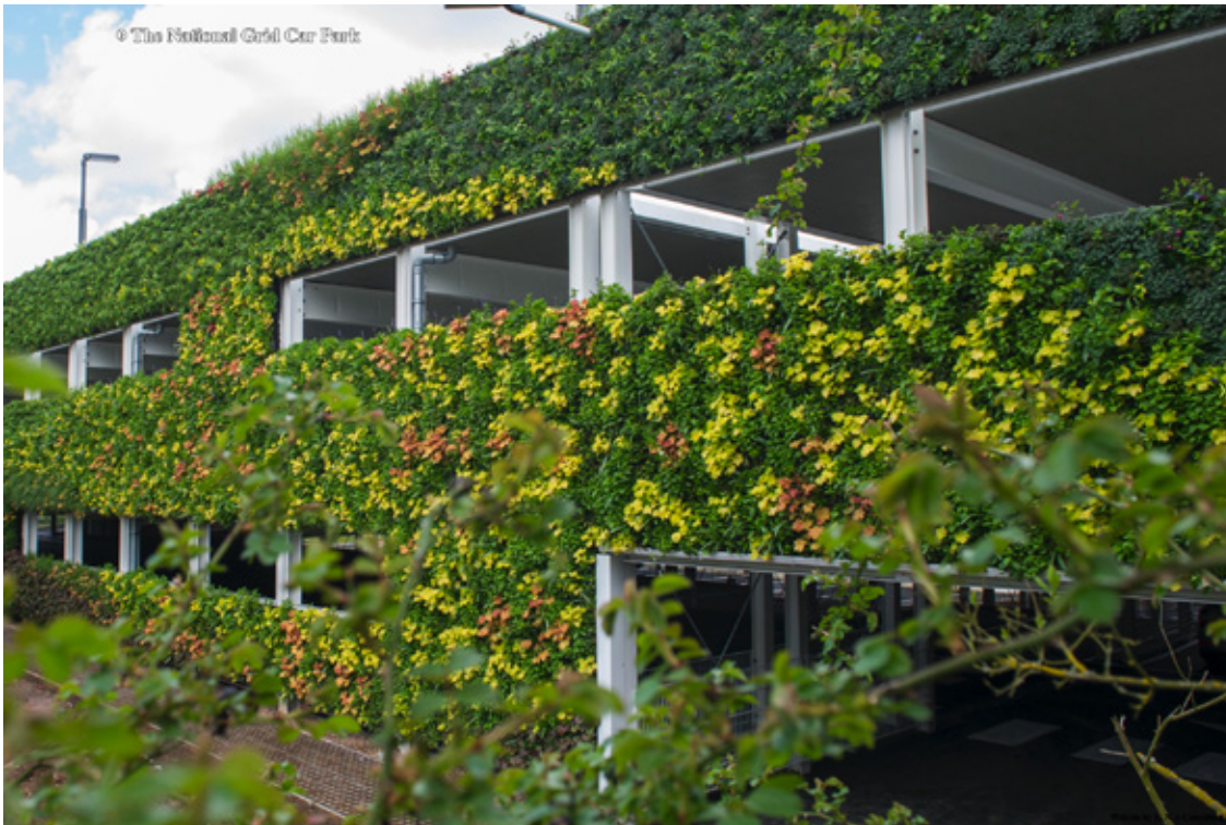
_Fig. 4: Structure de parking métallique avec façade verte, réalisée pour le National Grid House en Grande-Bretagne (photo: courtesy of 'National Grid', by One World Design Architects)
